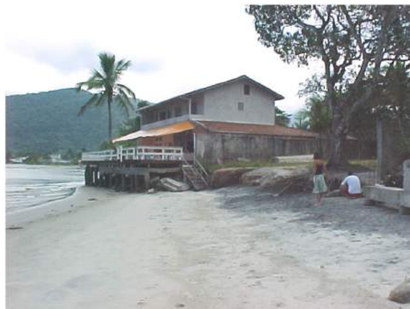
Figura 5. Forte erosão na porção SE da Praia de Tabatinga e construções sobre a pós-praia (Celia R. de G. Souza).
