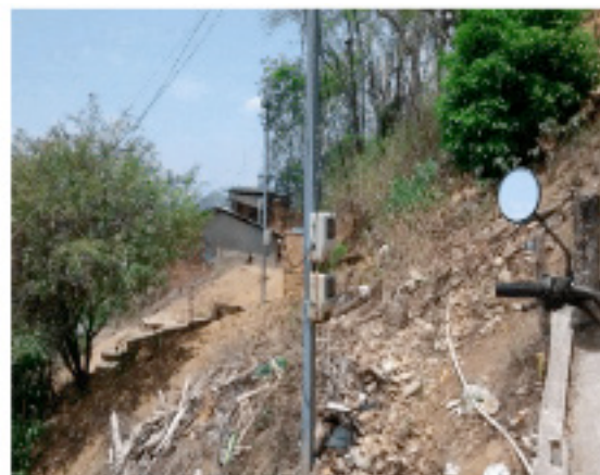
Figura 5 – Dispersão de resíduos nas encostas.
