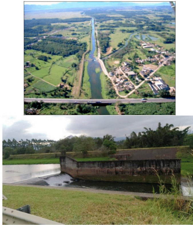
Figura 5 – Canal retificado e vertedor do Rio Cubatão do Norte (Fonte: Oliveira, 2006)
