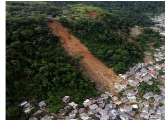
Figura 15 Deslizamento no Morro da carioca, Angra dos Reio, Rj 18
